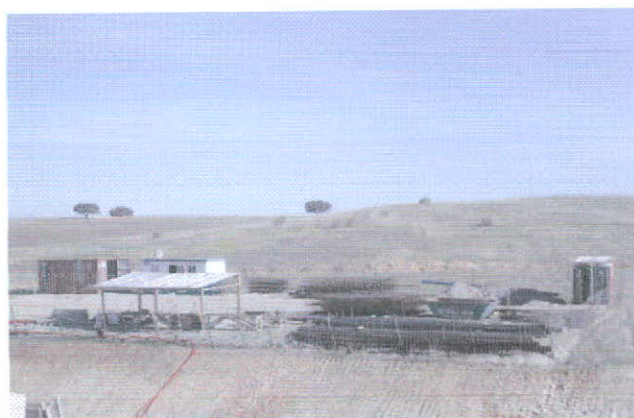
P11: Vista Geral do Estaleiro de Apoio da Estação Elevatória da Laje
