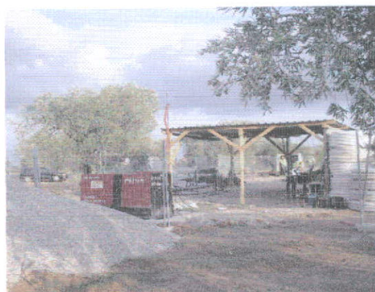
P12 Vista Geral do Estaleiro de Apoio do Reservatório dos Montinhos
